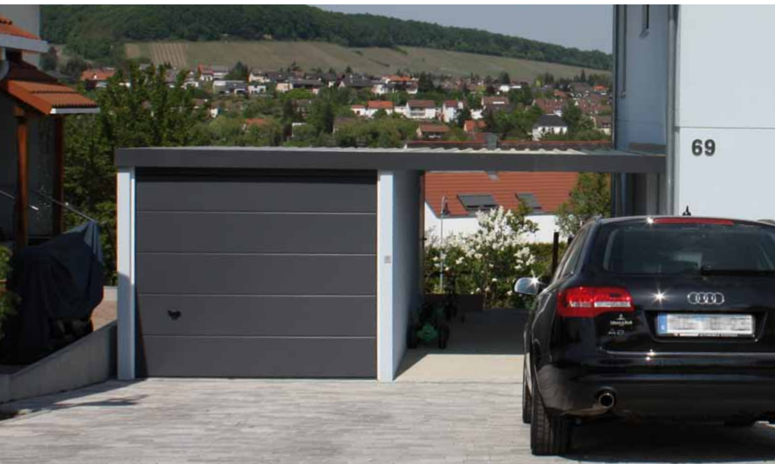
Kombinace garáže s garážovým stáním, rovná stěna s omítkou, sekční vrata
