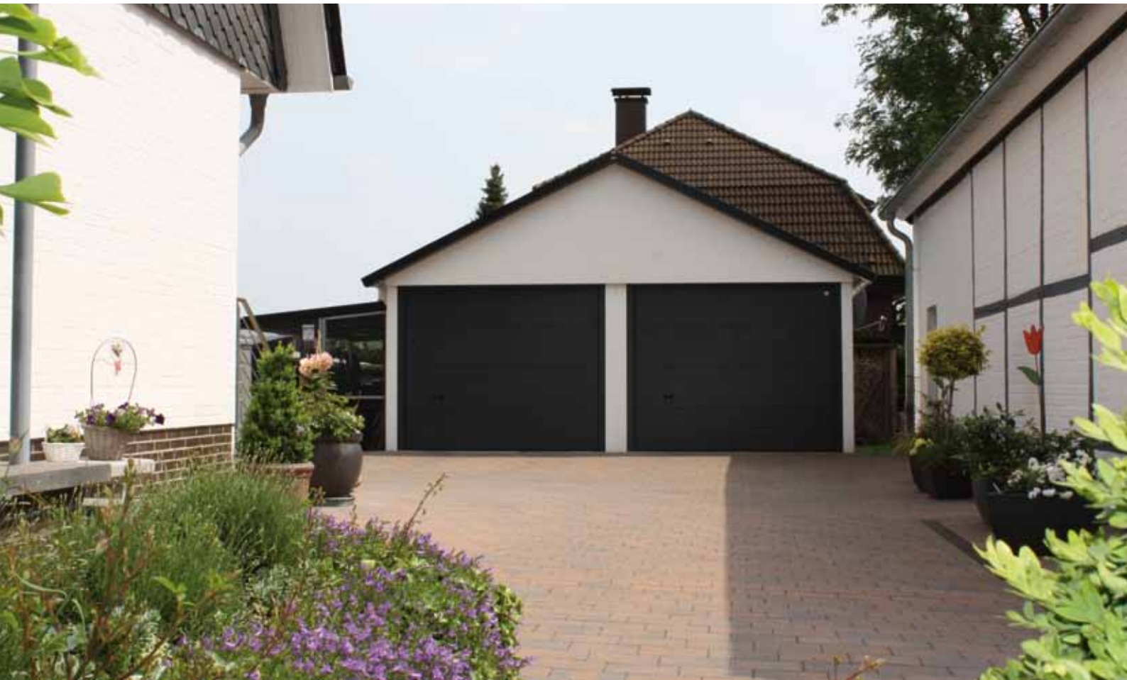
Dvojaráž se sedlovou střechou, sekční vrata
