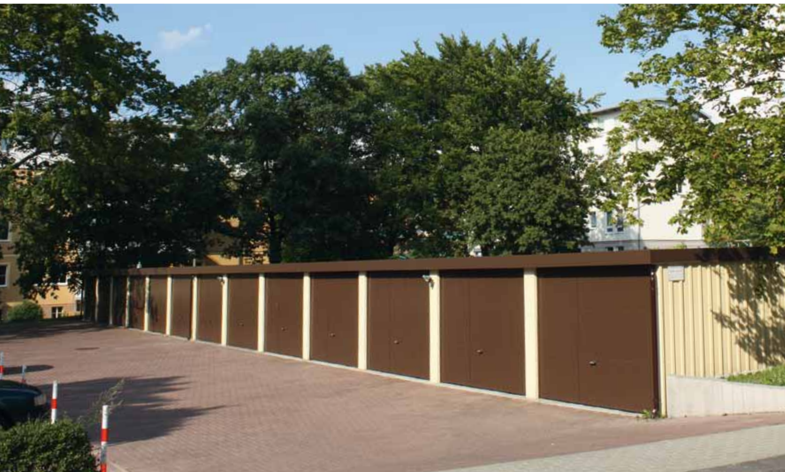
Řadová garáž, profilovaná stěna s omítkou, výklopná vrata, objekt z 2x 13 ks garáží
