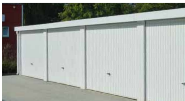
Řadová garáž, výklopná vrata
