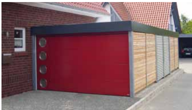
Carport – atypická konstrukce, uzavřeno stěnovými výplněmi a sekčními vraty
