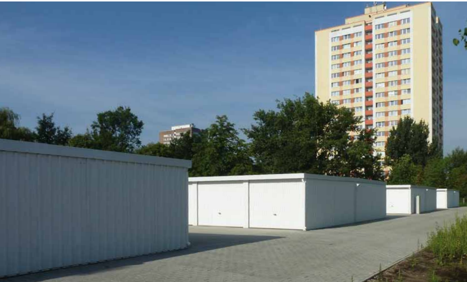
Areál řadových garáží, profilovaná stěna, výklopná vrata
