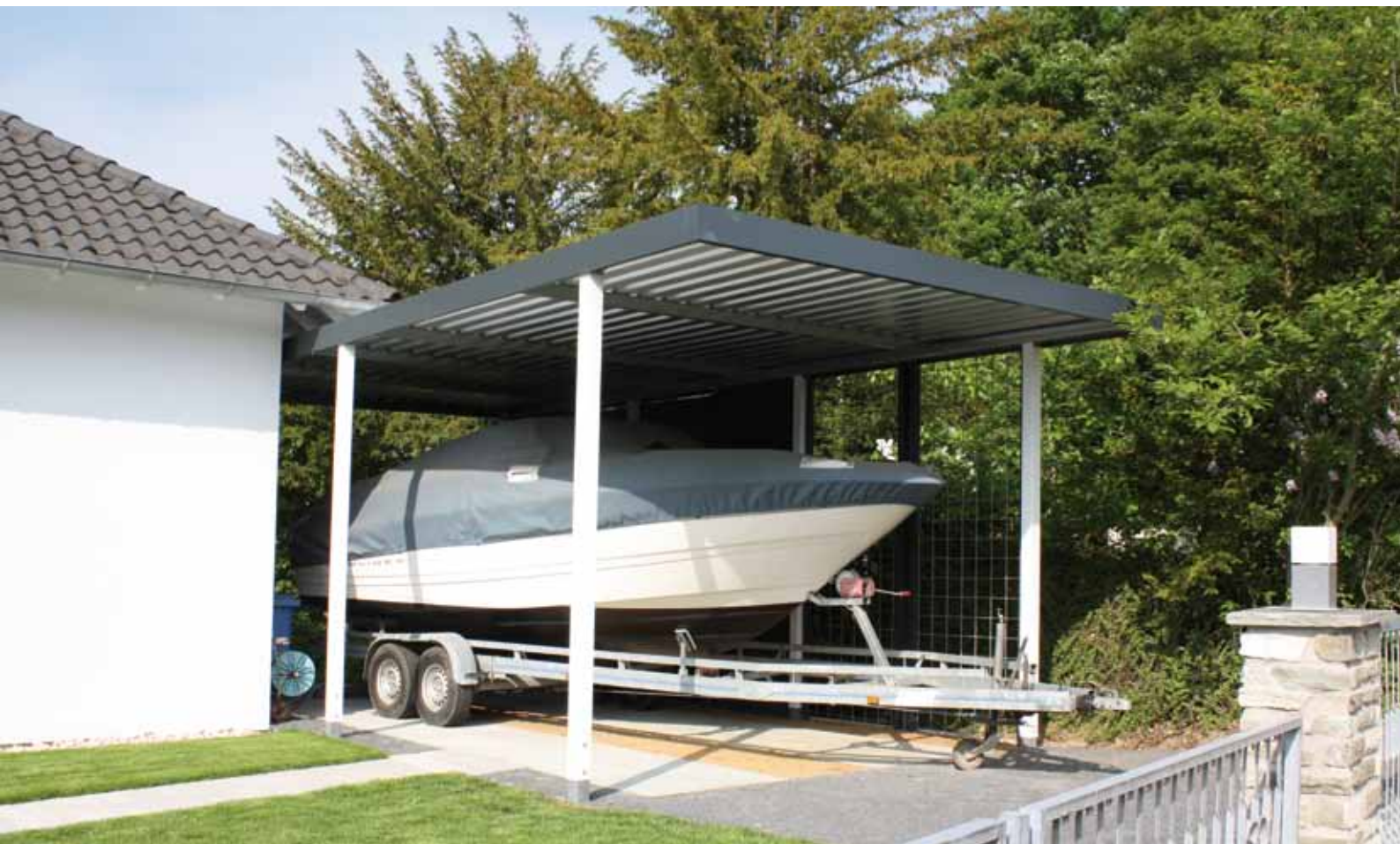
Konstrukce carportu se stěnovými výplněmi: vlnitý ocelový profil a pletená mříž
