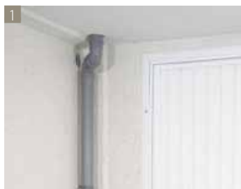
Odtékající dešťová voda se odvádí uvnitř garáže v zadní části, nebo na levé straně skrze podlahu.
