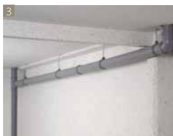
Garáž i její přístavba, v případě řadové garáže mohou být odvodňované společným odvodňovacím systémem pro více garáží.
